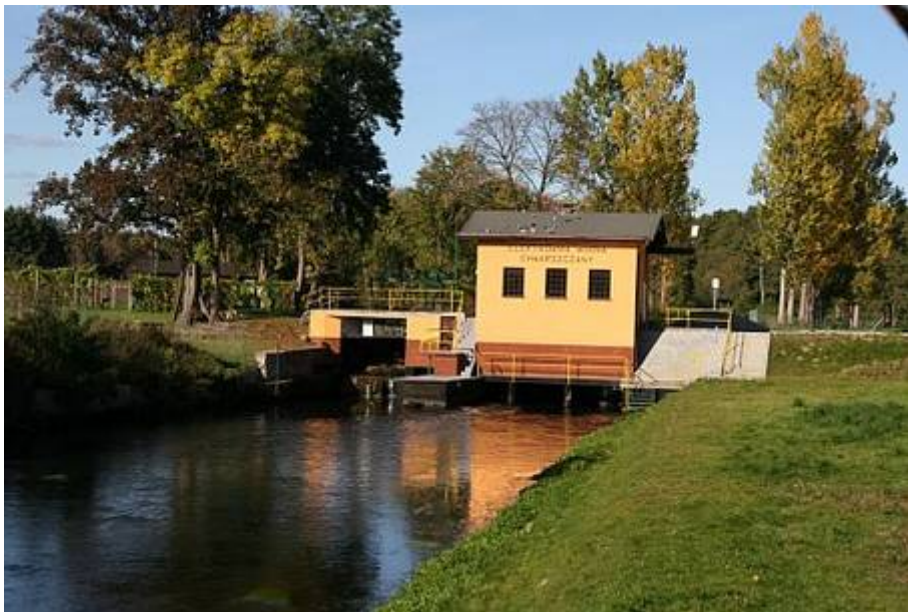
Ein modernes Wasserkraftwerk an der Mietzel versorgt Quartschen mit Strom.
